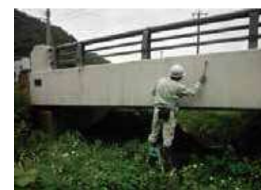
（橋の老朽化対策）
